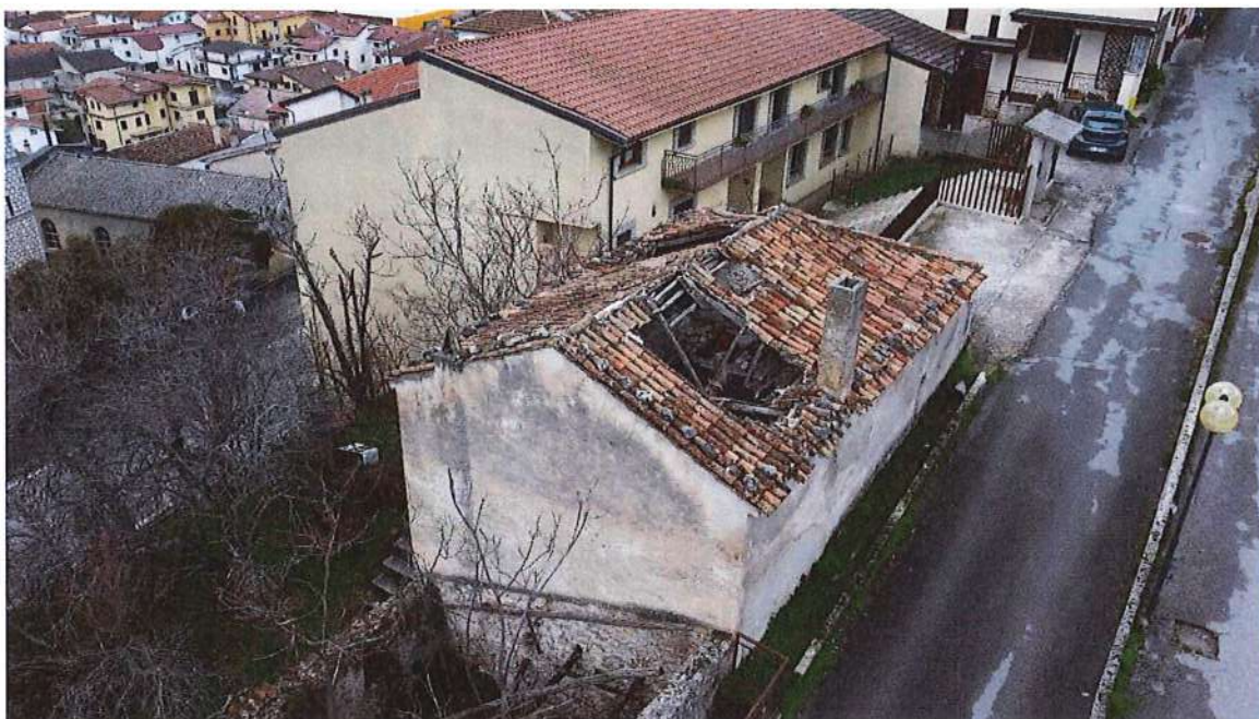
Figura 5 FOTO DRONE - PROS NORD
